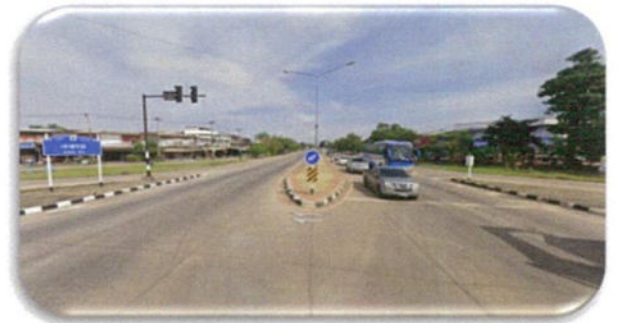
รูปที่ 4 แสดงสภาพปัจจุบันบริเวณจุดเริ่มต้นการก่อสร้างที่ กม.131+800 (แยกเขาทราย)
