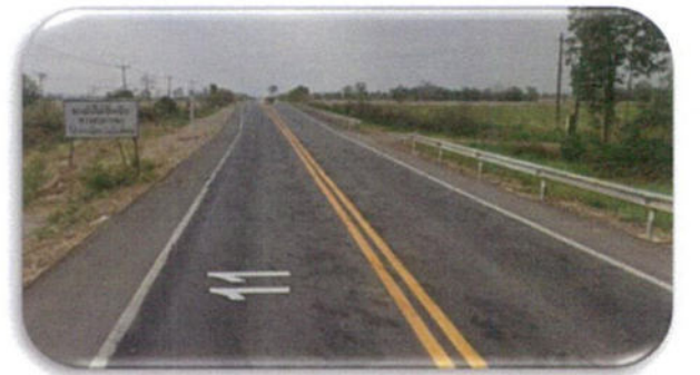
รูปที่ 5 แสดงสภาพปัจจุบันบริเวณจุดสิ้นสุดการก่อสร้างที่ กม.142+000 (บรรจบ 4 ช่องจราจรเดิม)
